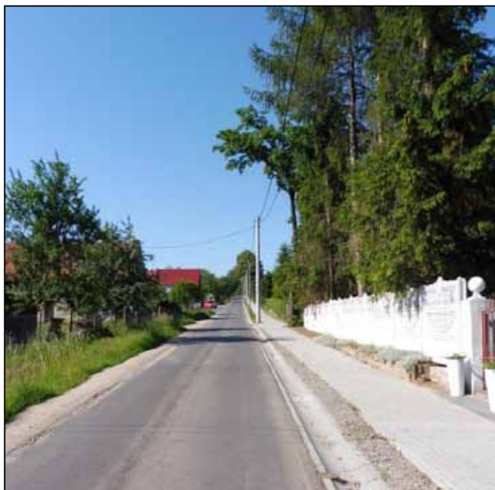
1. Budowa dróg gminnych w latach 2015-2018 1) Dobrocin 3.380.000 zł (drogi scaleniowe 6,21 km)
